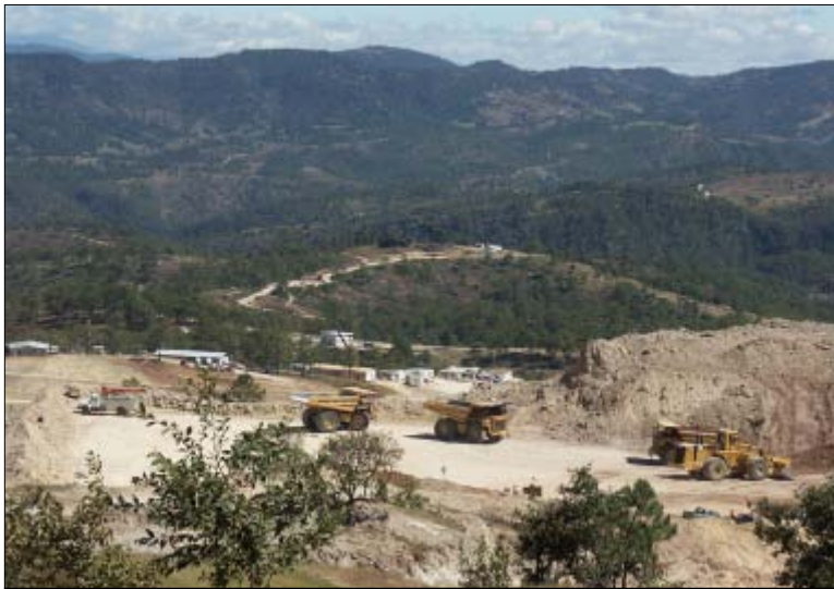
Construction of Glamis Gold's Marlin mine project in Guatemala. Photo courtesy Centro de Acción para el Desarrollo y el Derecho.
