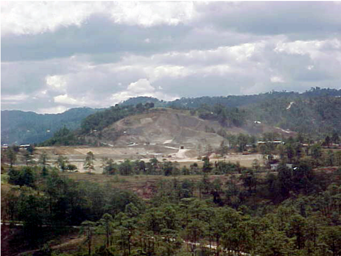
La Mina Marlin Bajo Construcción
