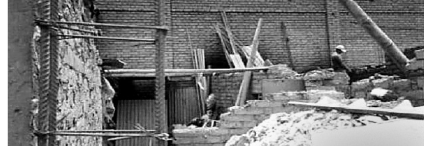
Chantier de construction au Pérou où on peut voir l'effritement de l'amiante chrysotile - Courtoisie des TCA
